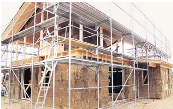
Wenn das Holzgerüst steht, können auch Laien die Strohballen aufschichten
