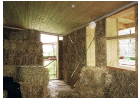
Holzständer können auch mit Strohballen ausgefacht werden (Foto r.). Friederike Fuchs, Britta Imhoff (Foto l., vorn Mitte, v. l.) und weitere Strohballenbauer/innen sind mit dem Deckenaufbau fertig. Mit den „Strohschwertern“ wurden zuvor die Lücken zwischen den Ballen verstopft. Fotos: STROH unlimited
