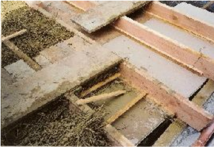
Coffrage provisoire sous toiture
