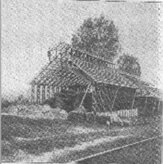
LA MAISON DE PAILLE EN COURSE DE CONSTRUCTION. LE TOIT EST EN PAILLE ET LES MURS EN BOIS.
