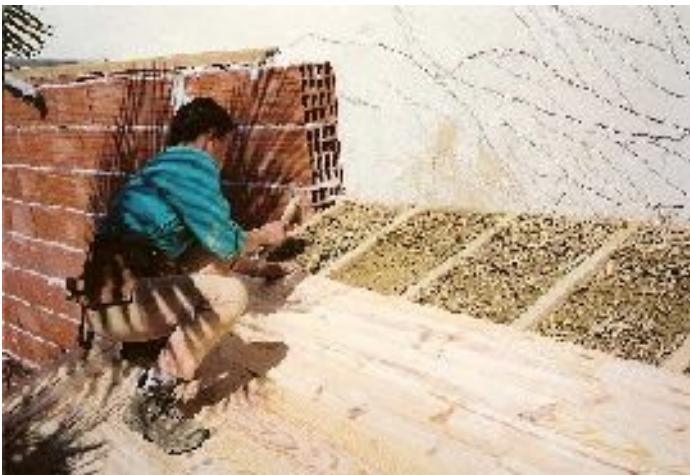
Fermeture de l'isolant (parquet)
