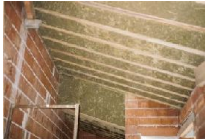
Vue de dessous (débanchage immédiat)
