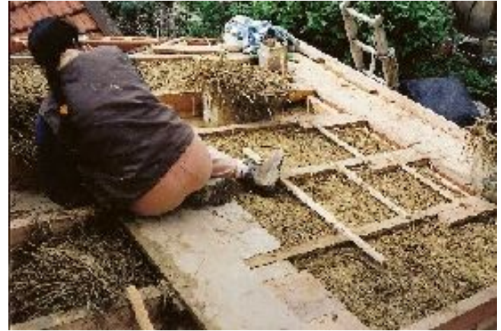
Remplissage par dessus
