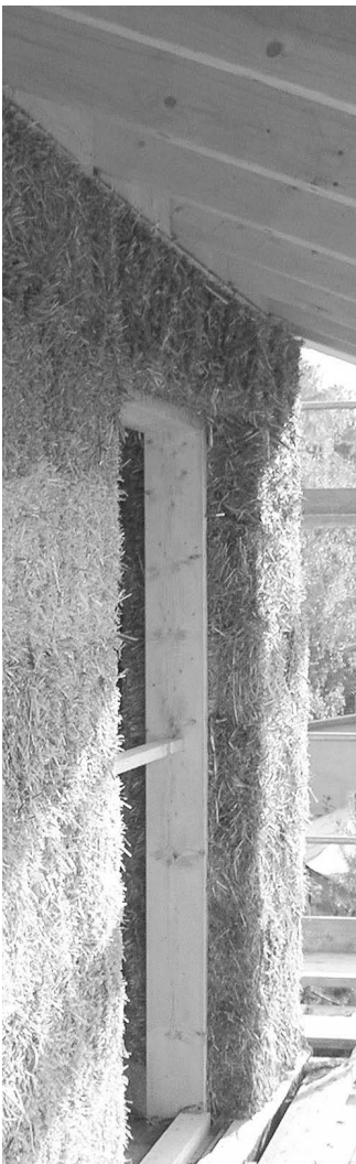
Unverputzte Strohballenwand in Sachsen Anhalt. Foto: fasba/ Dirk Scharmer, 2004
